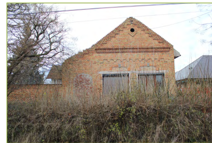
Durván, érzéketlenül beépített új ablakok egy régi téglahomlokzatba.
