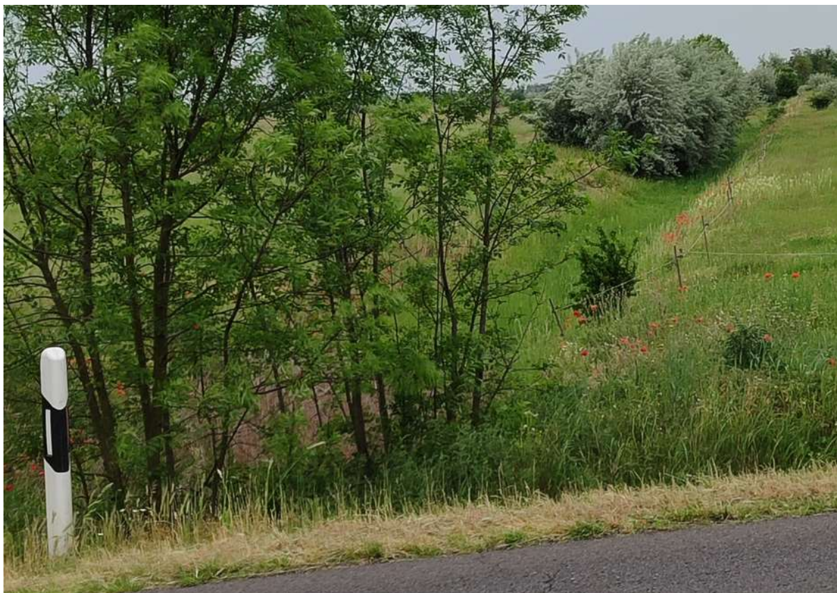
41. ábra: A Felső főcsatorna növényzettel fákkal benőtt területe
