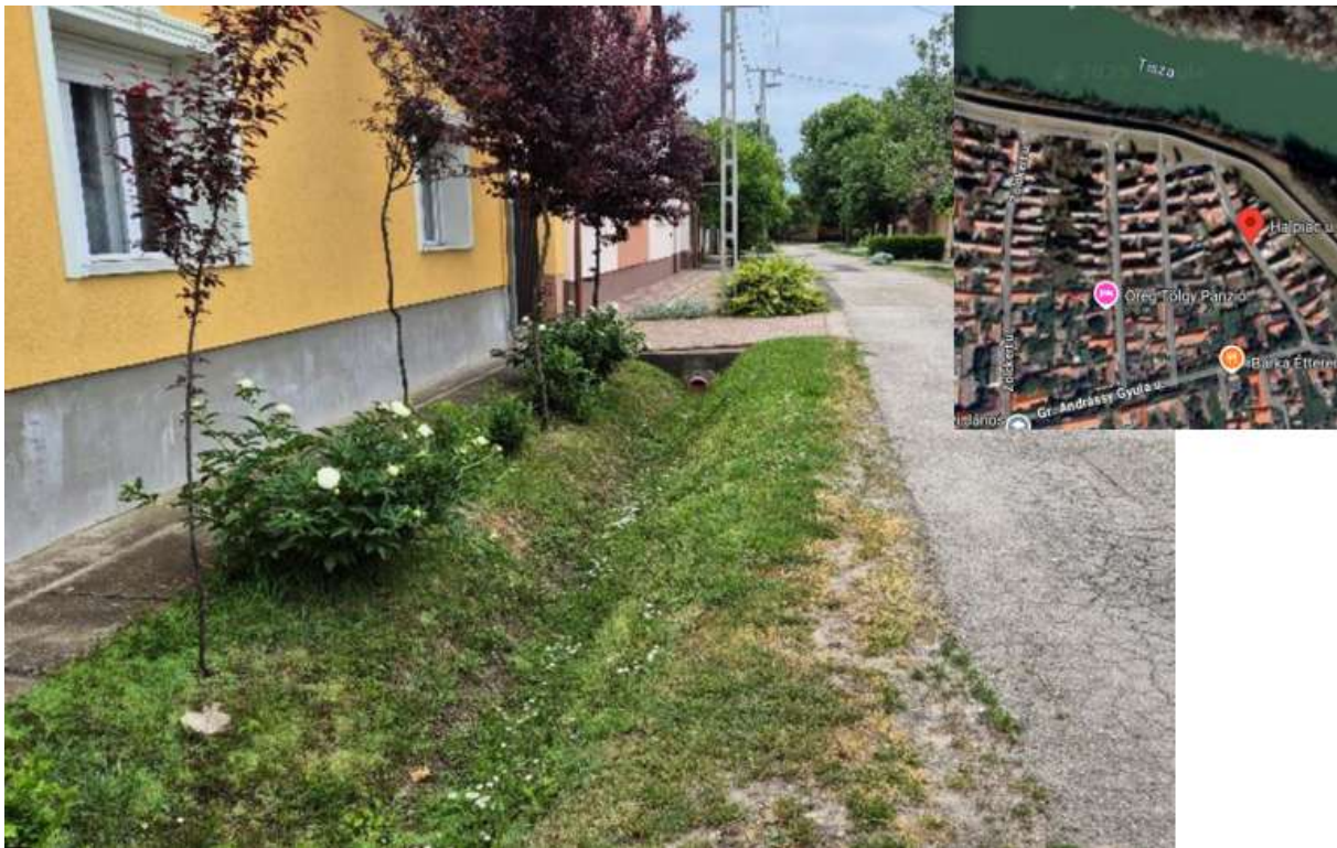
34. ábra: Halpiac utca – feltöltődött csatorna
