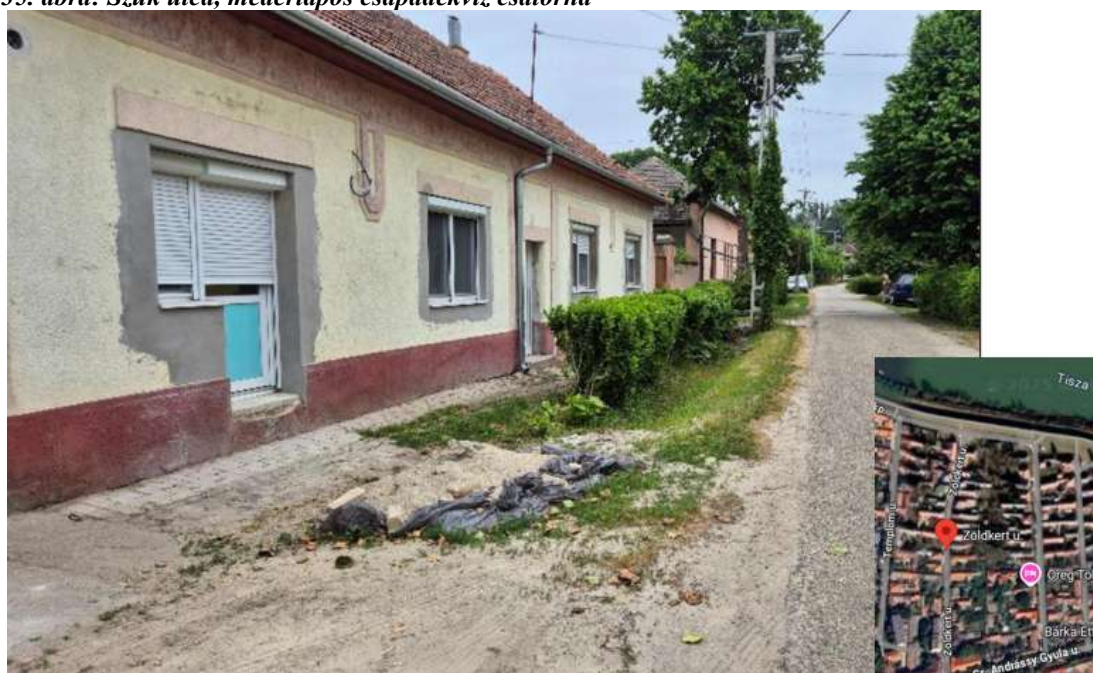
36. ábra: Zöldkert utca, feltöltődött csapadékvíz-csatorna
