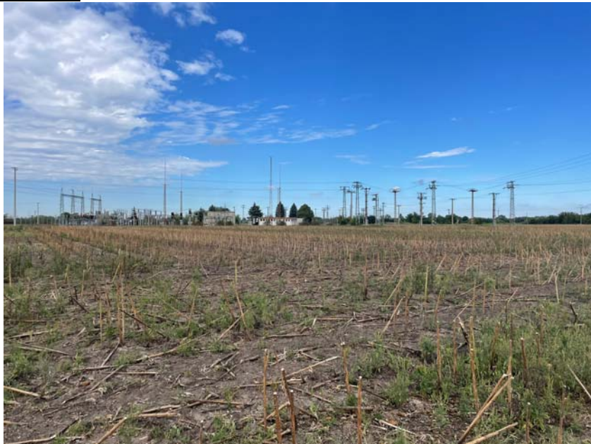
Trafóállomás, előtérben a Csongrád 17272 az. Temető-dűlő lelőhely /napraforgótarló/
