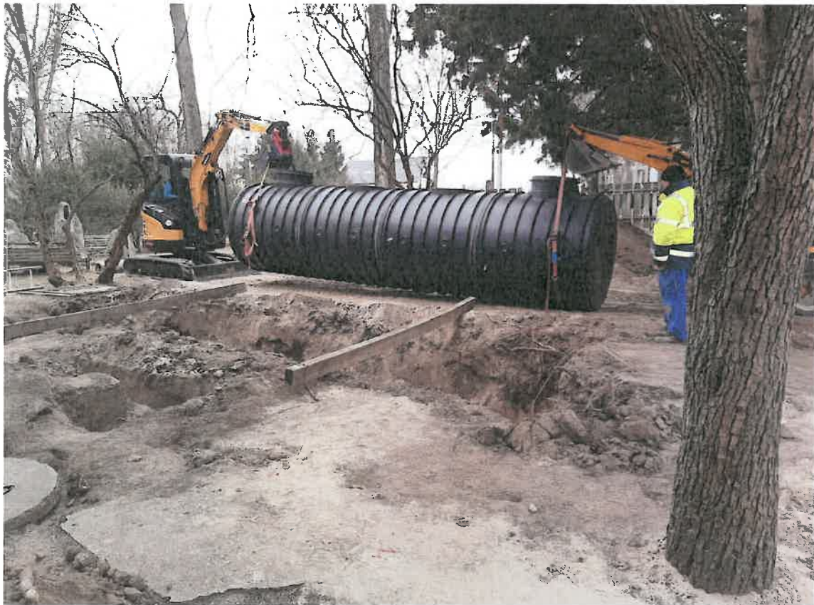
Kókai kft. munkatársai szennyvíztartály telepítése közben
