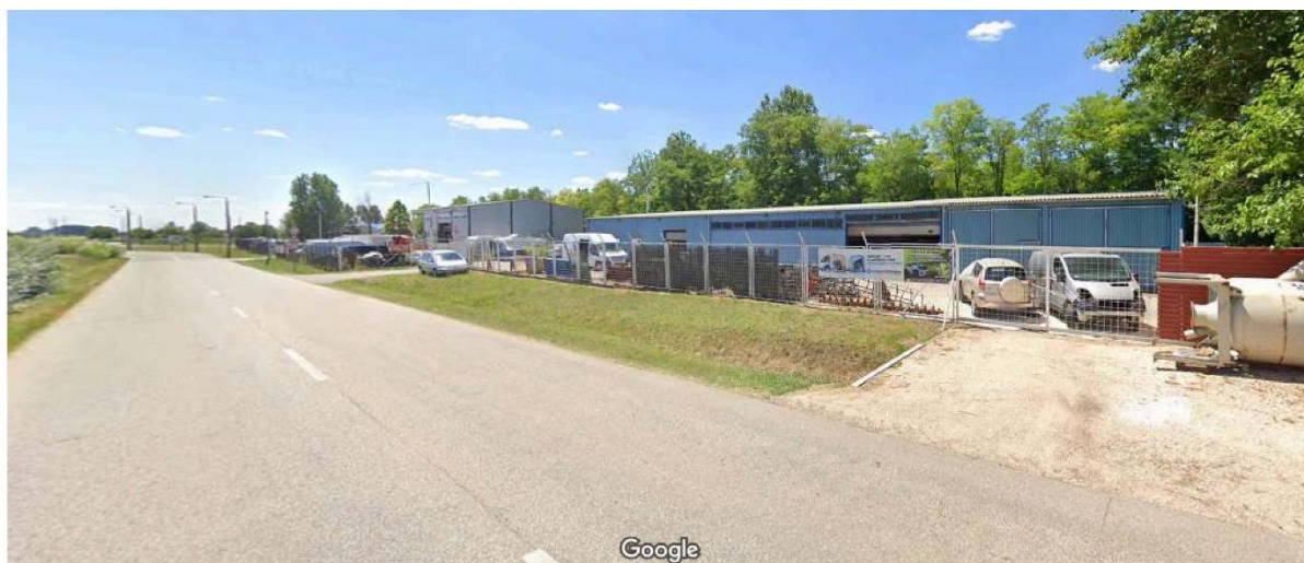
Palackozó üzem épülete az ipari park elkerülő út felől a körforgalom irányába
